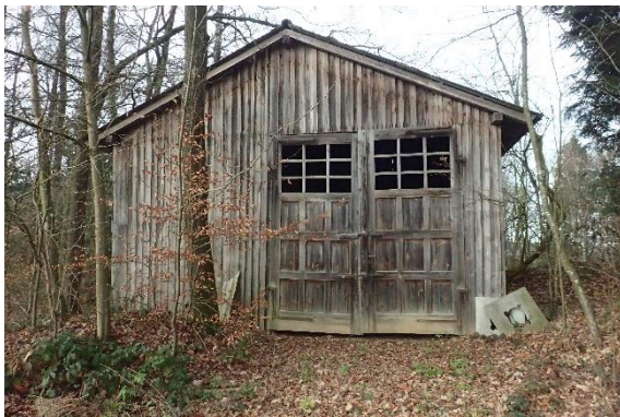
16.12.2019: Blick von Südosten auf den Schuppen
