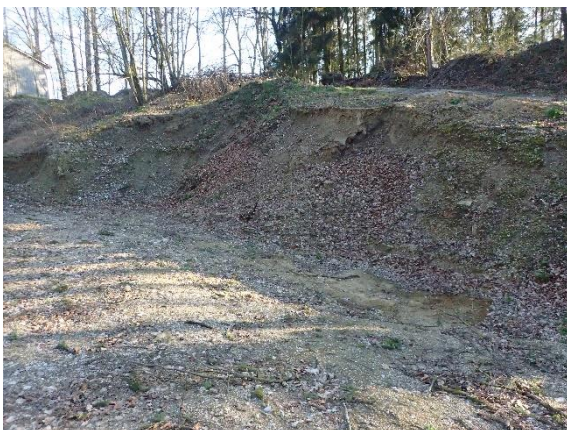
18.03.2020: Die westliche Böschung unterhalb der nach oben führenden Zufahrt.
